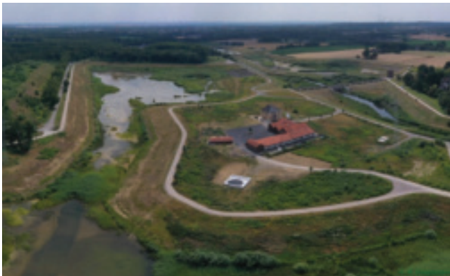
Becken 3 und Emscherauenhof
